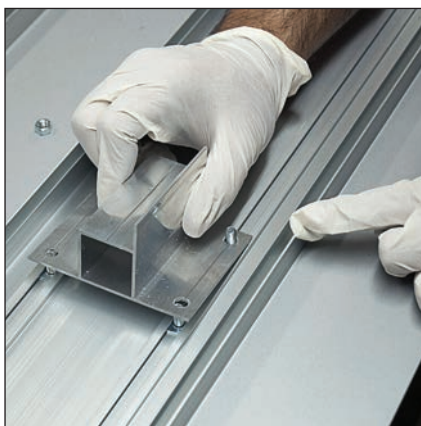
Fissaggio fazzoletti
